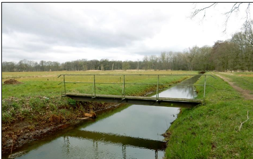
Figuur 59: Te verwijderen brug
