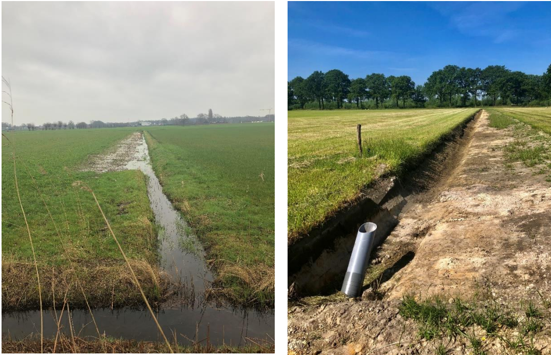
Figuur 3: Natuurvriendelijke oevers op P3. Links: vóór aanvang van het onderzoek, sloten gevuld met water. Rechts: tijdens het onderzoek, sloten bijgewerkt met nieuwe duiker (voorground).
