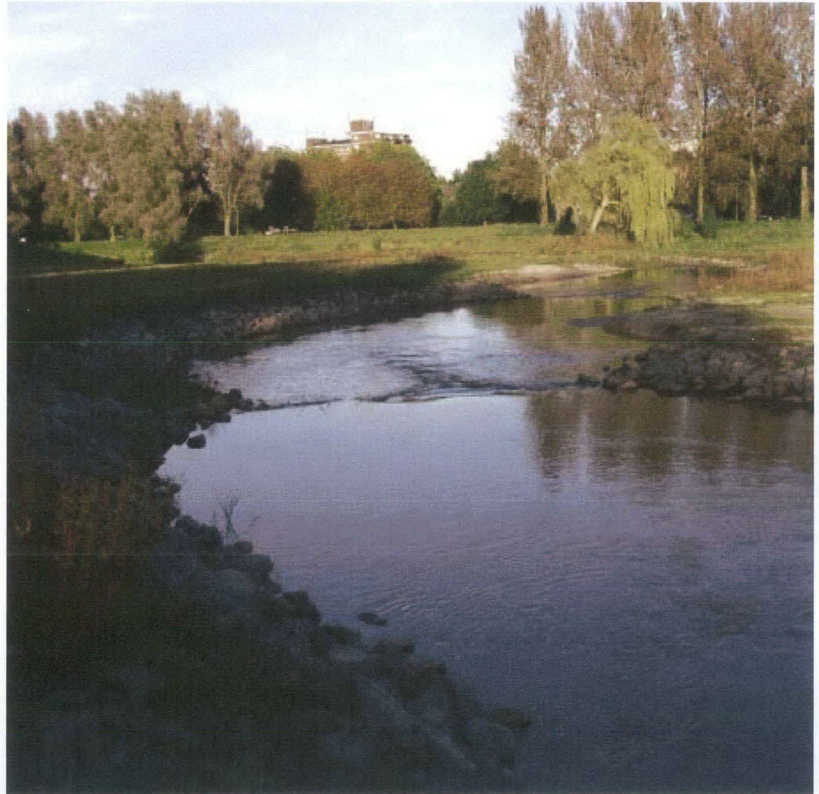
Figuur 39: voorbeeld van een vistrap over de gehele breedte van de watergang
