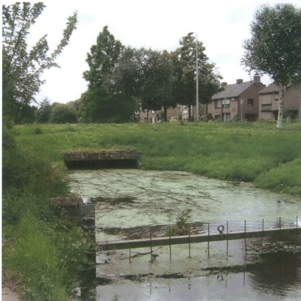
Figuur 35: voorbeeld van drie obstakels: vuilrooster, vaste stuw en kokerduiker
