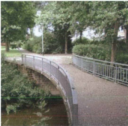
Figuur 6: wandel- en fietsbrug
