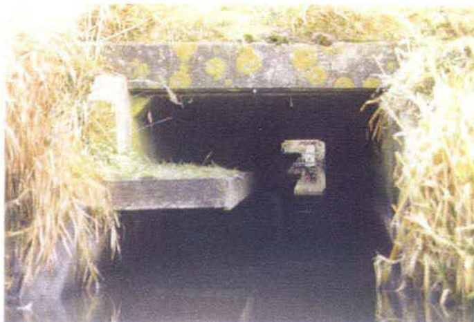
Figuur 4.6 De zogenaamde 'ecoduiker' onder Rijksweg A59. Door het ontbreken van faunageleidende voorzieningen en dekkingbiedende vegetatie functioneert deze voorziening in de huidige situatie niet naar wens.
