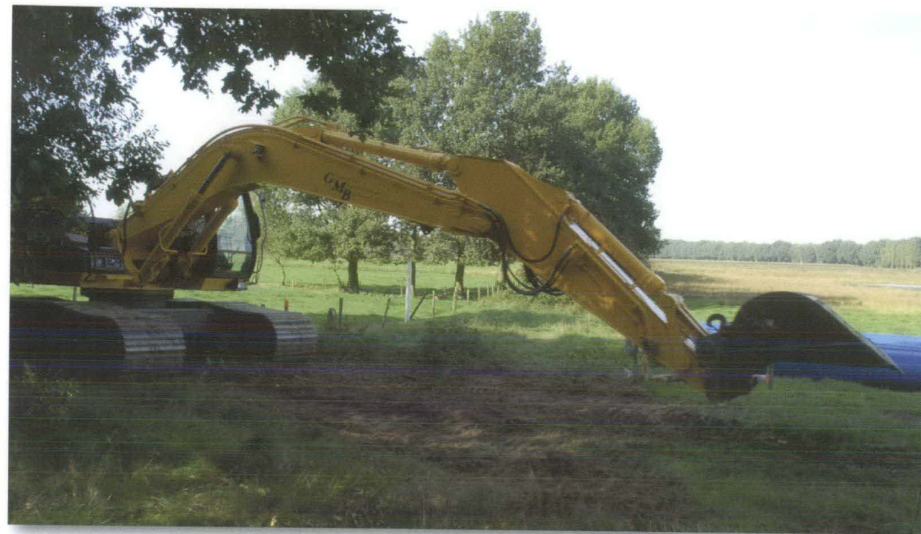
Natuurtechnisch ontgraven met een mesbak
