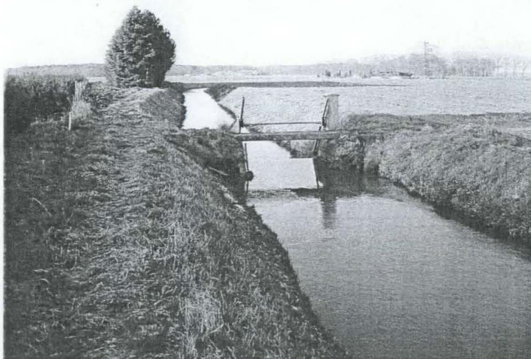
Foto 2 Stuw in de Raamsloop
