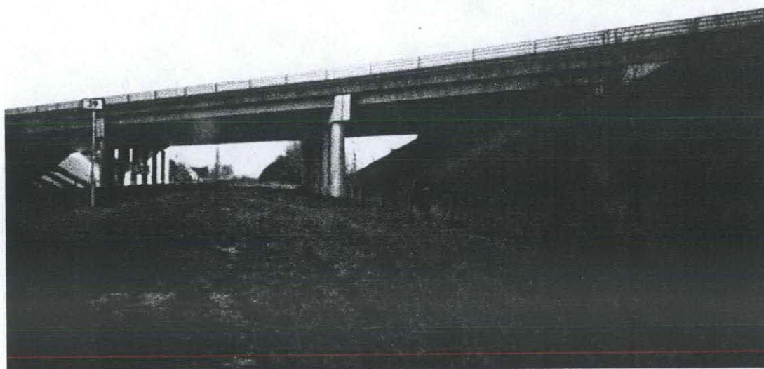
Afbeelding 23: Beugenseweg doorgang A77 in zuidelijke richting (doorvoer open bypass Raam plaatselijk in betonnen goot)
