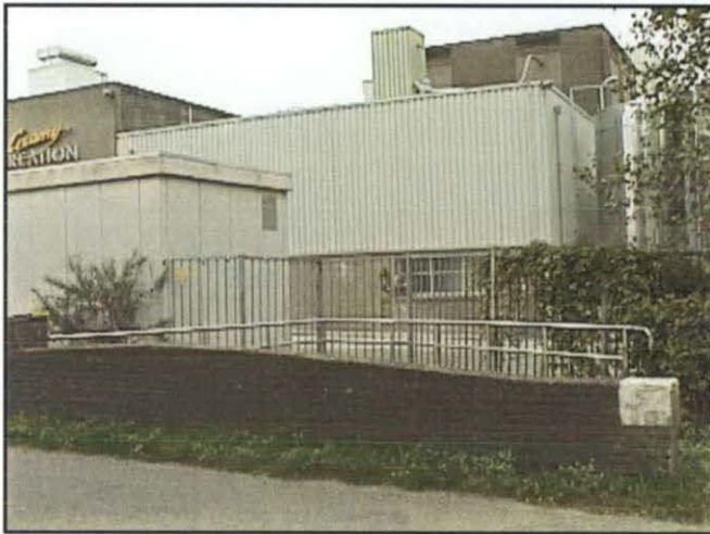
De overkluizing bij Campina: een belangrijk op te lossen knelpunt.
